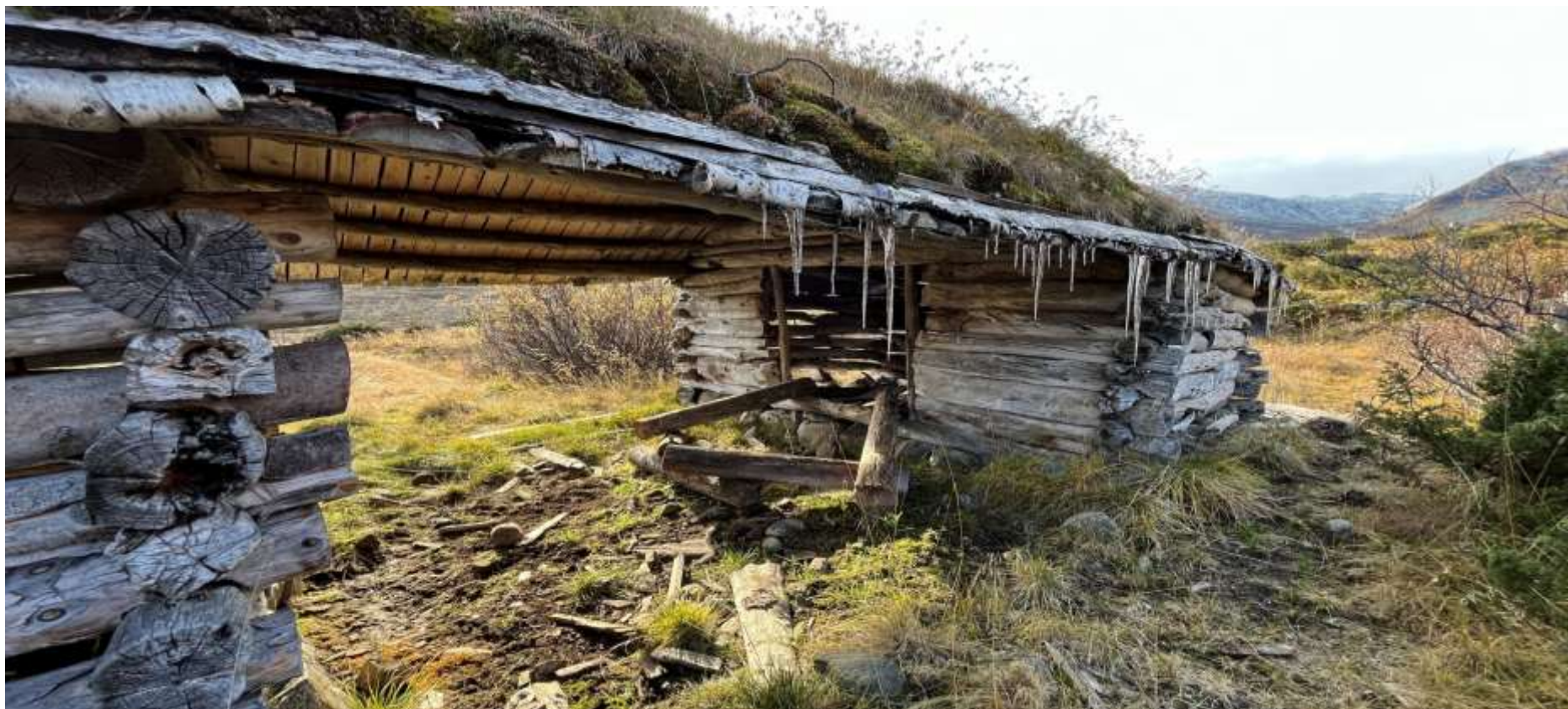
Restaurert læ i Bulien, tilrettelagt for ein rast under tett tak.
