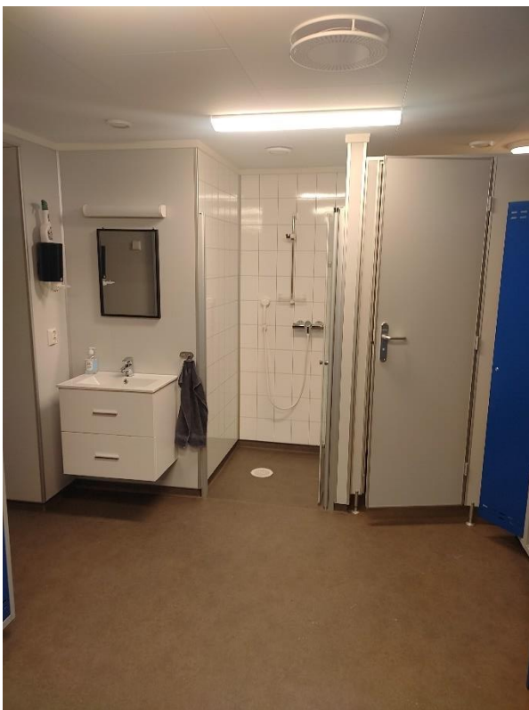
Dusj i same rom som herregarderoben med blanding av rein og urein sone, ingen barriere mellom rein og urein sone.
