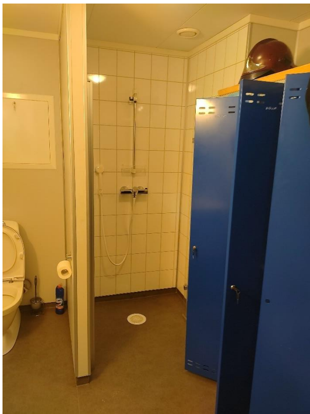
Det same avviket med damegarderoben, i tillegg er det få plassar.
