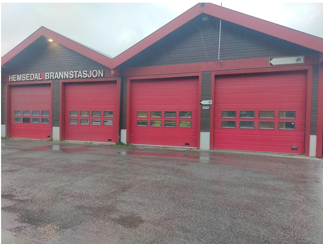
Dei tre portane lengst til høgre er til brannstasjonen.
