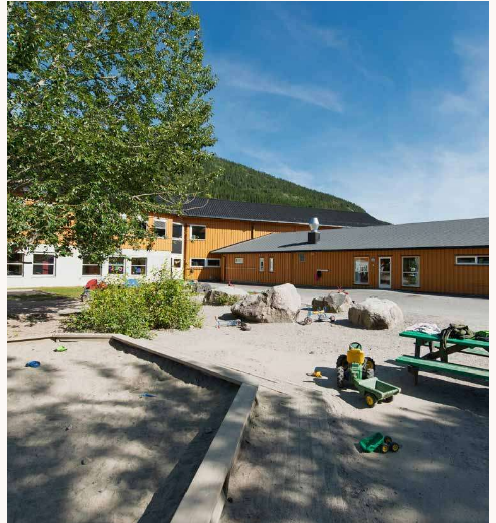
Inntunet mellom byggene BUILT
