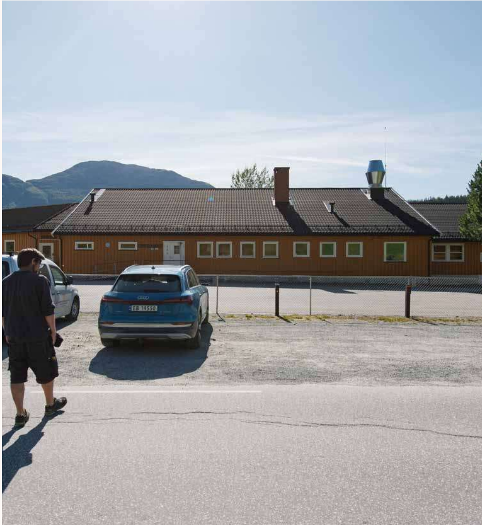
Skolebygget fra nord
