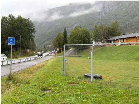
Dagens grøft og avskjerming fra vei
