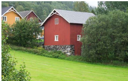
Støttemurer i området
