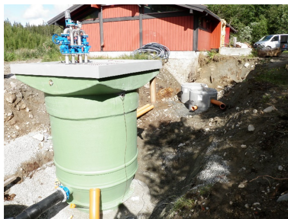
FIGUR 13. BILDER FRA BYGGING AV NY INNLØPPSPUMPESTASJON PÅ ULSÅK I 2010
