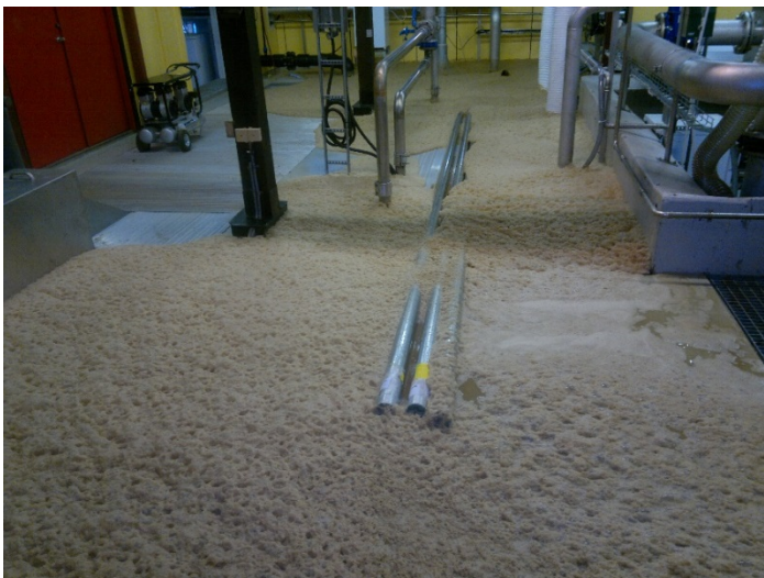
FIGUR 21. EKSTREM SKUMDANNELSE I BIOLOGISK RENSETRINN SOM FØLGE AV INDUSTRIPÅSLIPP. HENDELSEN FANT STED DEN 22.10.2013.
